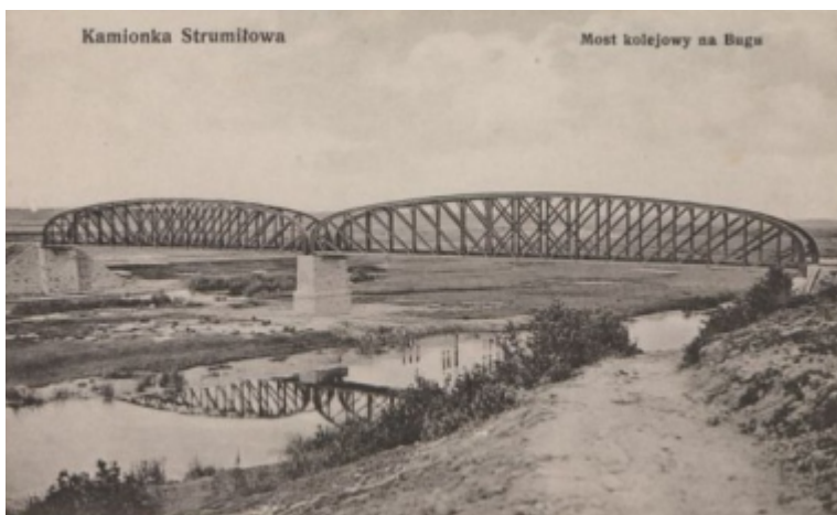
Kamionka Strumiłowa, most kolejowy na Bugu.
